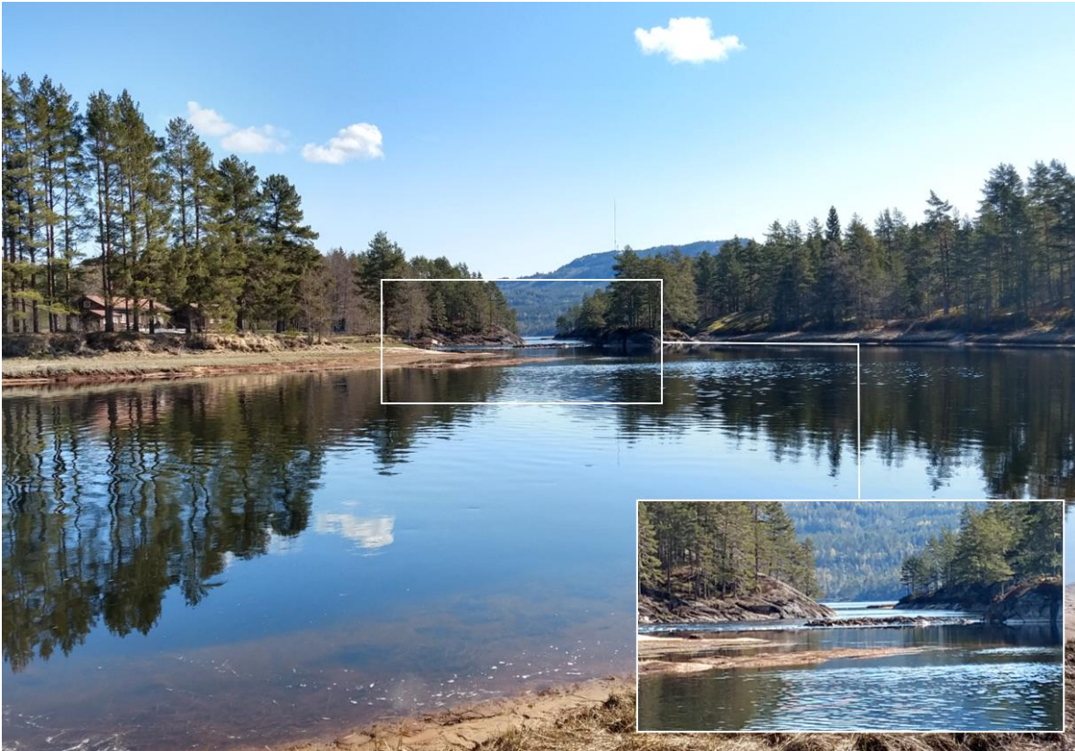
Figur 15 Terskel før utløpet i Nelaug-magasinet.
