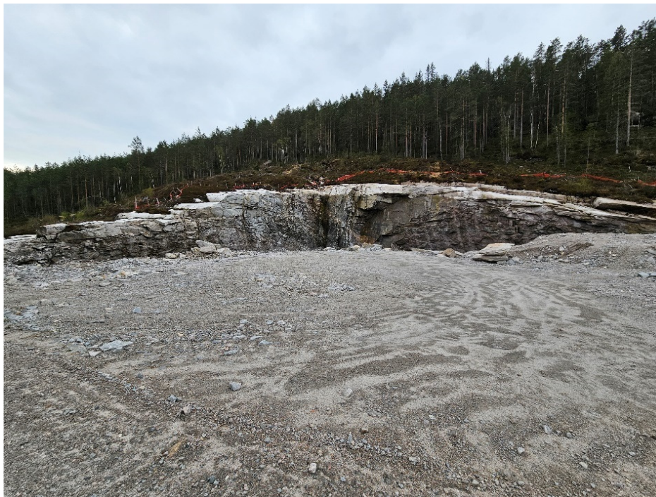
Figur 7 Bilde som viser omtrentlig høyde på fjellskjæring
